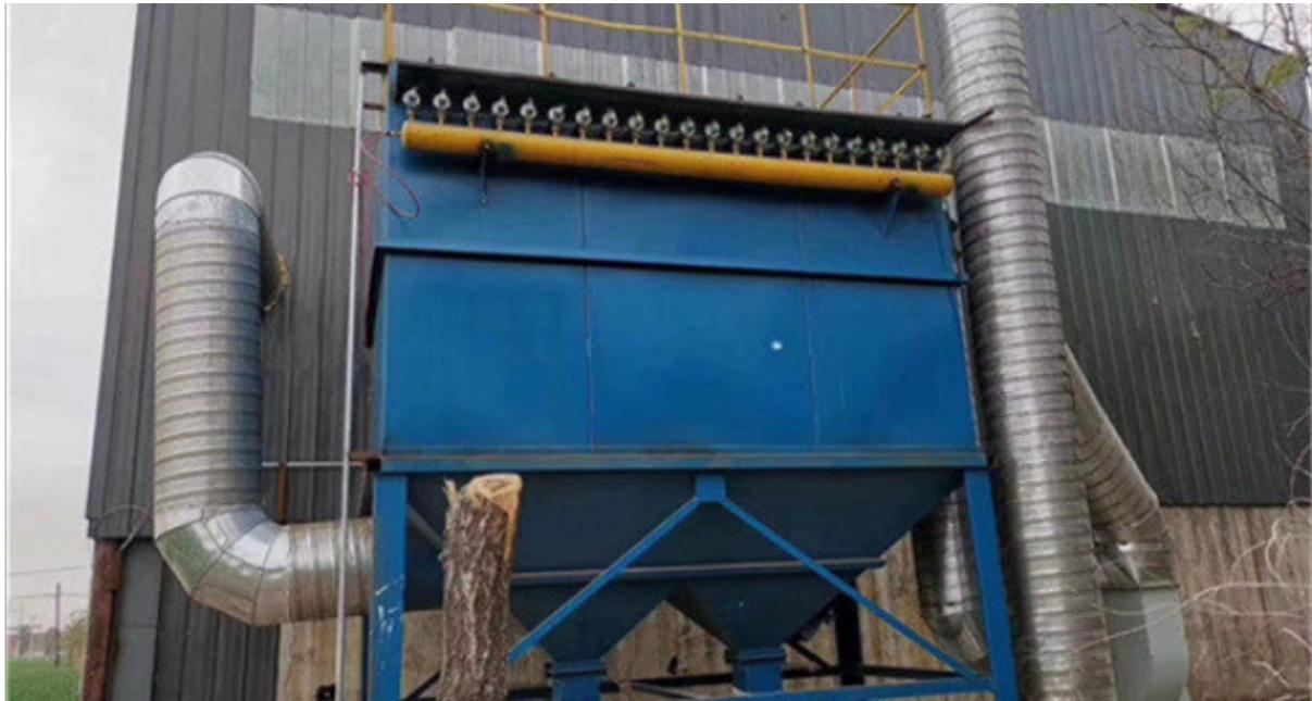
布袋除尘器除尘器的工作原理如下：含尘气体由下部敞开式法兰进入过滤室，较粗颗粒直接落入灰仓，含尘气体经滤袋过滤，粉尘阻留于袋表，净气经袋口到净气室，由风机排入大气。当滤袋表面的粉尘不断增加，程控仪开始工作，逐个开启脉冲阀，使压缩空气通过喷口对滤袋进行喷吹清灰，使滤袋突然膨胀，在反向气流的作用下，赋予袋表的粉尘迅速脱离滤袋落入灰仓，粉尘由卸灰阀排出。除尘器主要由上箱体、中箱体、灰斗、进风均流管、支架滤袋及喷吹装置、卸灰装置等组成。含尘气体从除尘器的进风均流管进入各分室灰斗，并在灰斗导流装置的导流下，大颗粒的粉尘被分离，直接落入灰斗，而较细粉尘均匀地进入中部箱体而吸附在滤袋的外表面上，干净气体透过滤袋进入上箱体，并经各离线阀和排风管排入大气。随着过滤工况的进行，滤袋上的粉尘越积越多，当设备阻力达到限定的阻力值（一般设定为 $1500\text{Pa}$ 时，由清灰控制装置按差压设定值或清灰时间设定值自动关闭一室离线阀后，按设定程序打开电控脉冲阀，进行停风喷吹，利用压缩空气瞬间喷吹使滤袋内压力聚增，将滤袋上的粉尘进行抖落（即使粘细粉尘亦能较彻底地清灰）至灰斗中，由排灰机构排出。
